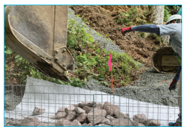
重機による石の投入が可能
