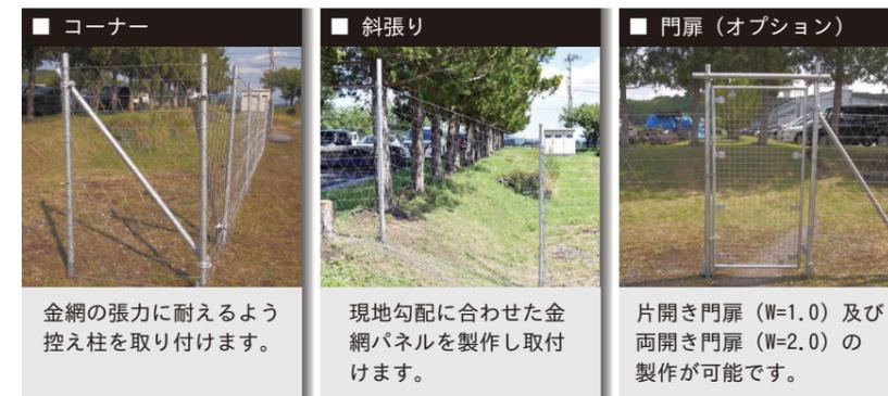
金網の張力に耐えるよう控え柱を取り付けます。
